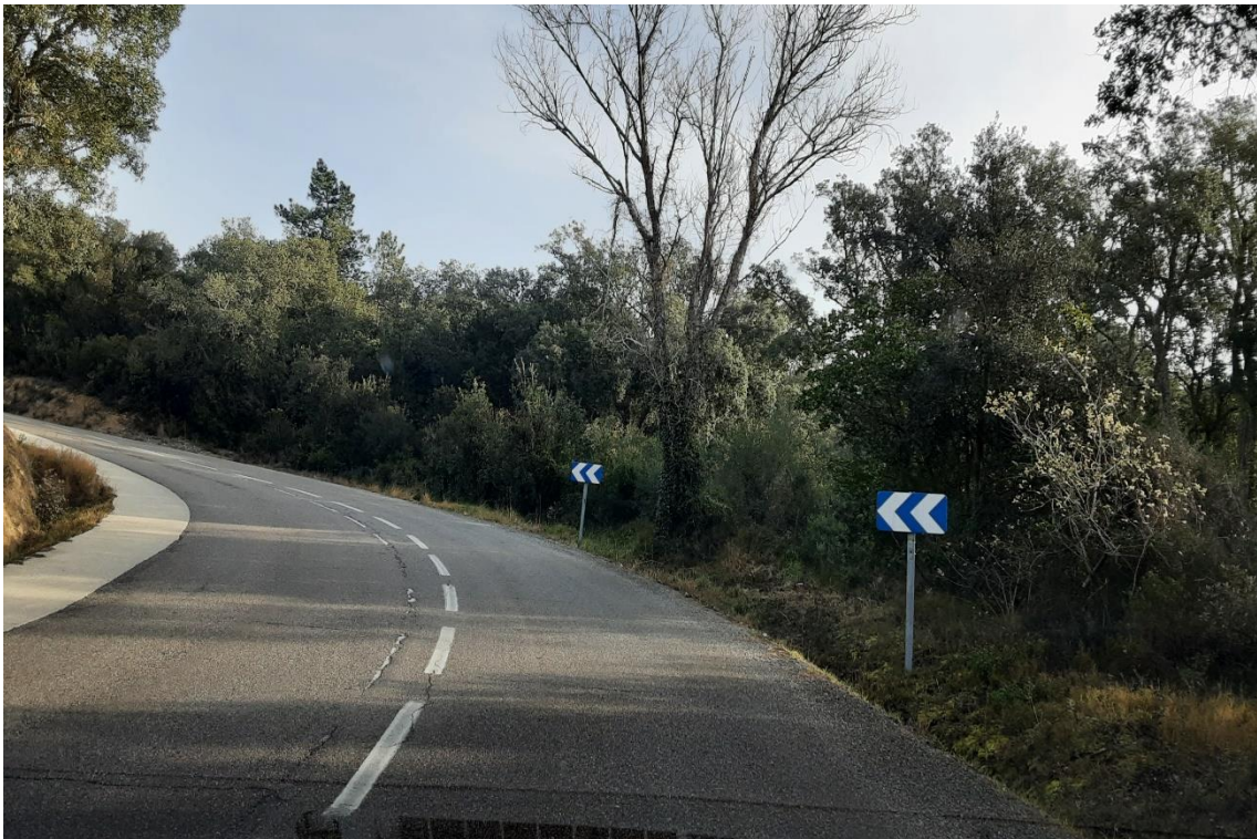
Figura 14. Vista de la calçada al PK 6+500, en sentit Calonge
