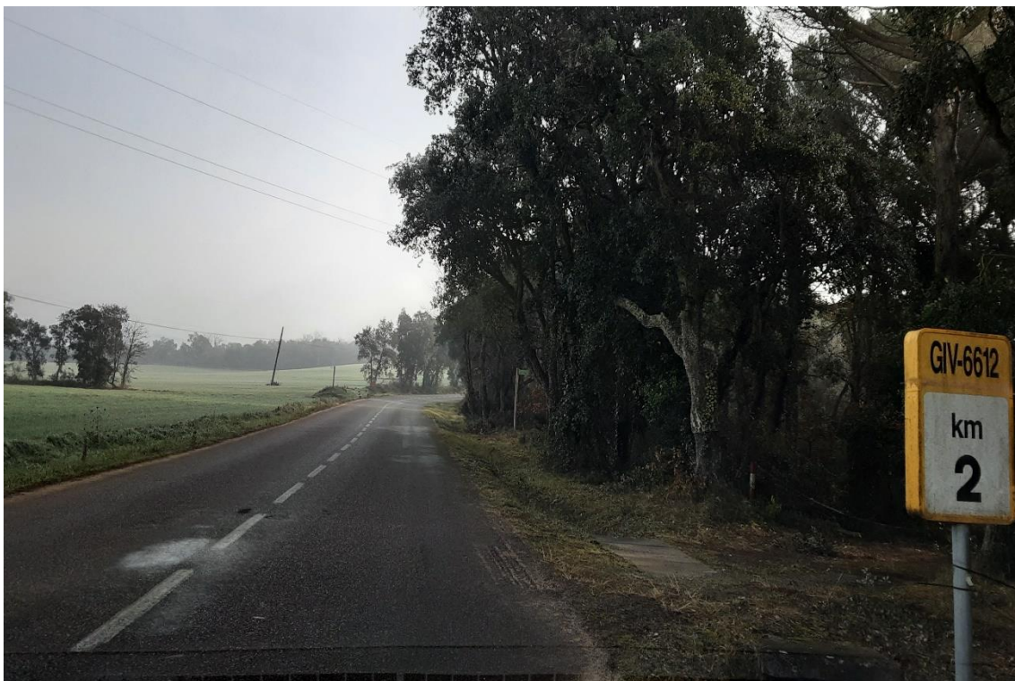
Figura 5. Vista de la calçada al PK 2+000, en sentit Calonge
