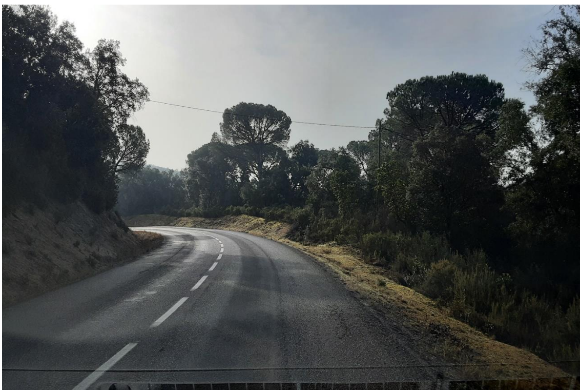
Figura 12. Vista de la calçada al PK 5+500, en sentit Calonge
