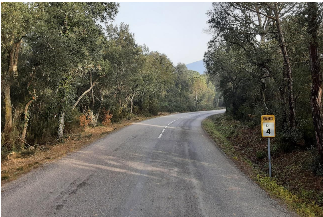
Figura 9. Vista de la calçada al PK 4+000, en sentit Calonge
