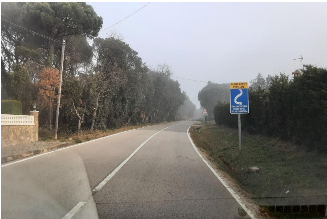
Figura 1. Vista de la calçada al PK 0+1050, en sentit Calonge
