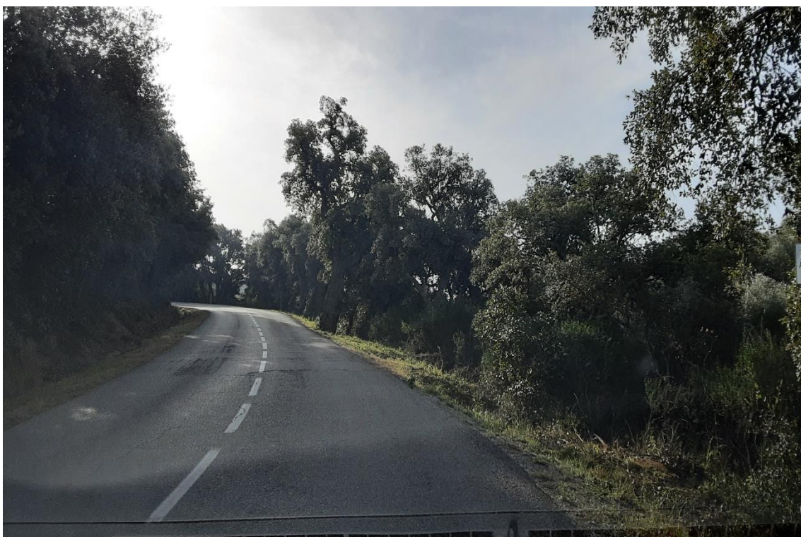
Figura 16. Vista de la calçada al PK 7+500, en sentit Calonge
