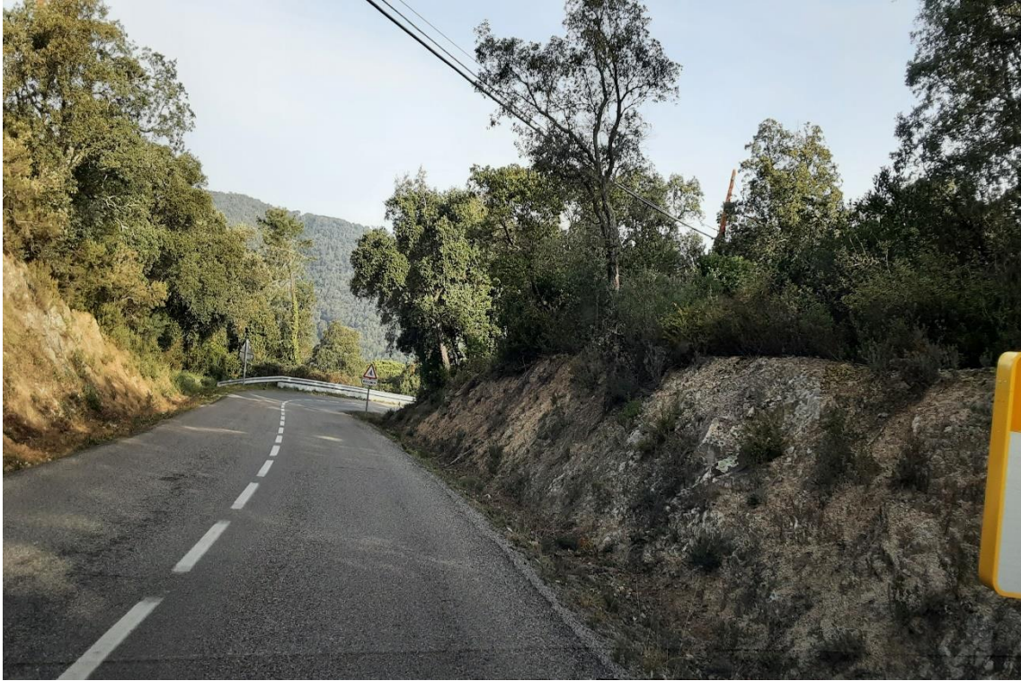
Figura 19. Vista de la calçada al PK 9+000, en sentit Calonge
