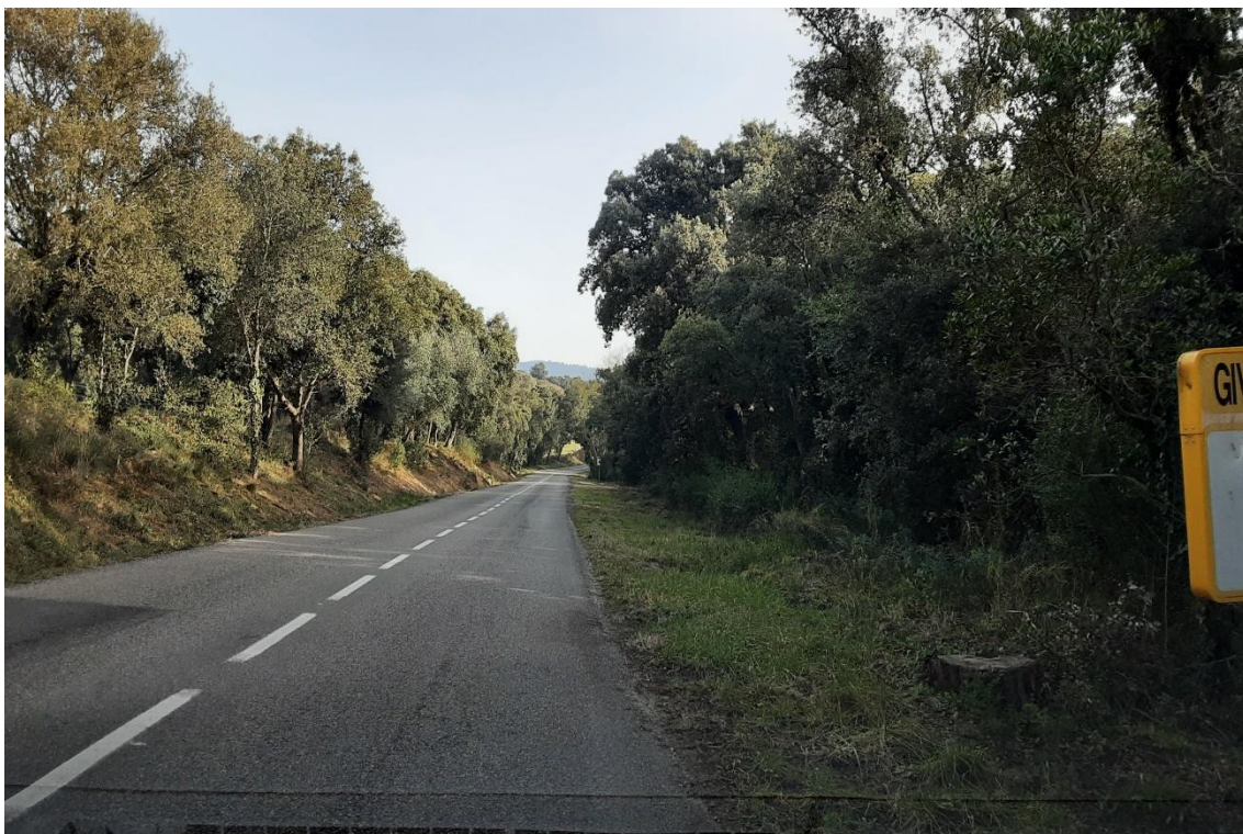
Figura 17. Vista de la calçada al PK 8+000, en sentit Calonge
