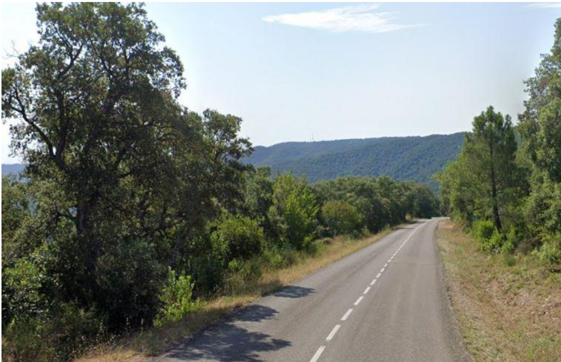
Figura 20. Vista de la calçada al PK 9+190, en sentit Calonge
