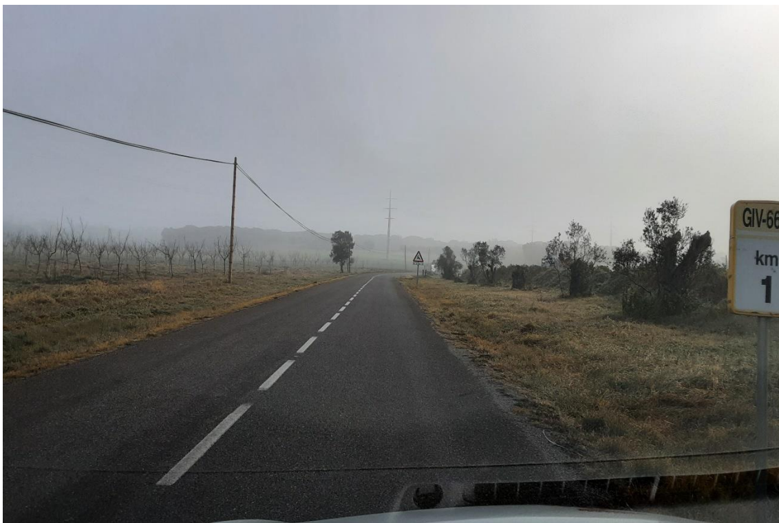
Figura 3. Vista de la calçada al PK 1+000, en sentit Calonge
