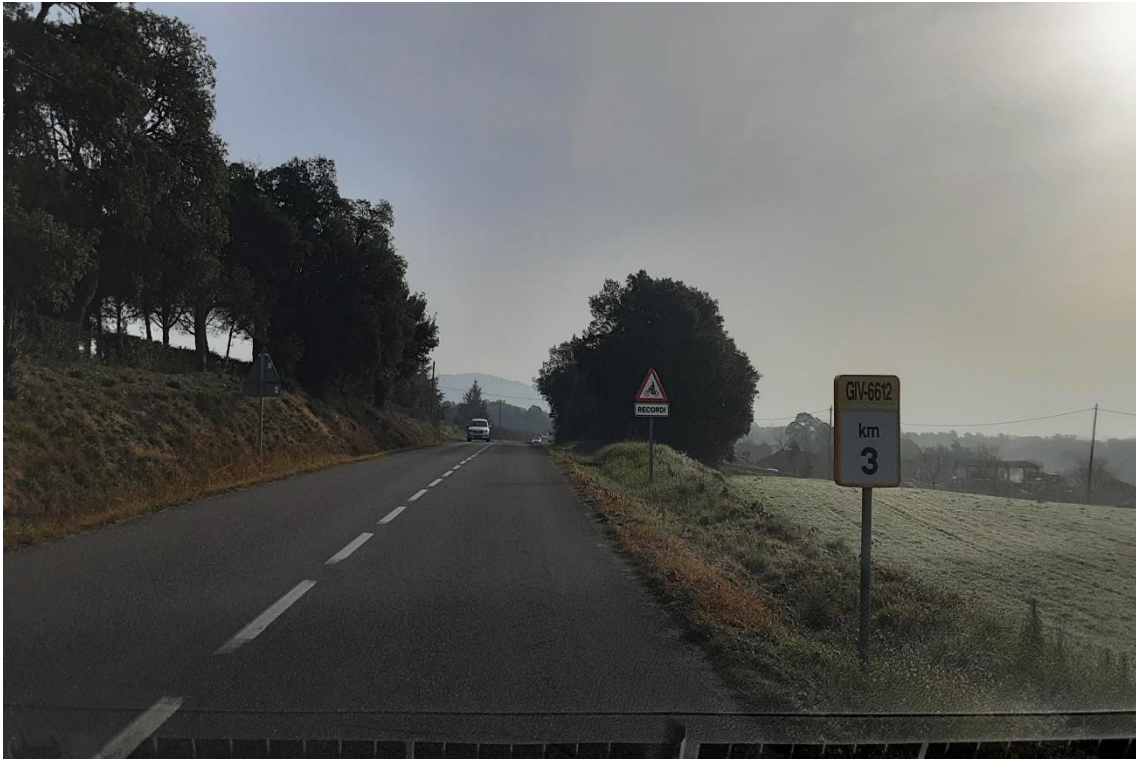
Figura 7. Vista de la calçada al PK 3+000, en sentit Calonge
