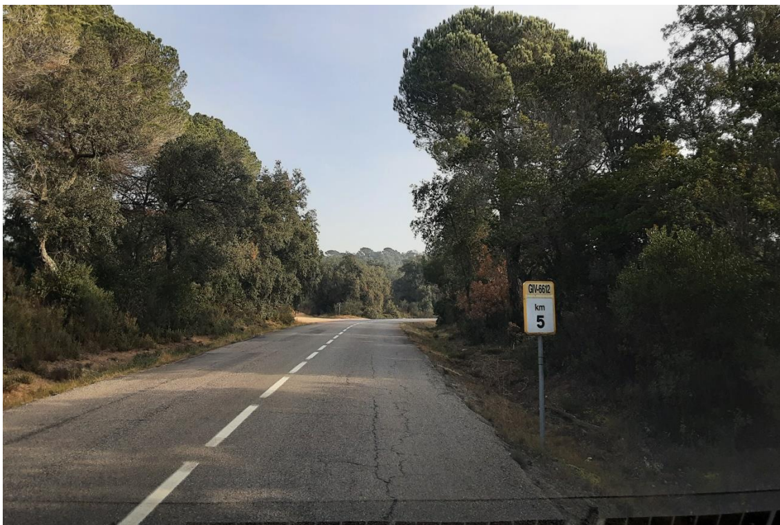
Figura 11. Vista de la calçada al PK 5+000, en sentit Calonge
