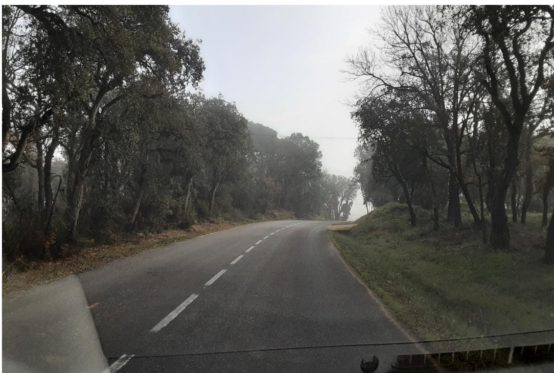
Figura 2. Vista de la calçada al PK 0+1550, en sentit Calonge
