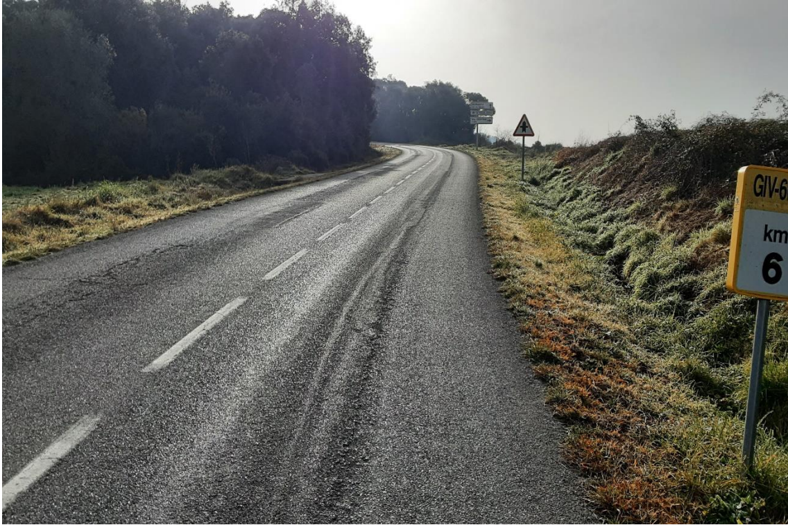
Figura 13. Vista de la calçada al PK 6+000, en sentit Calonge
