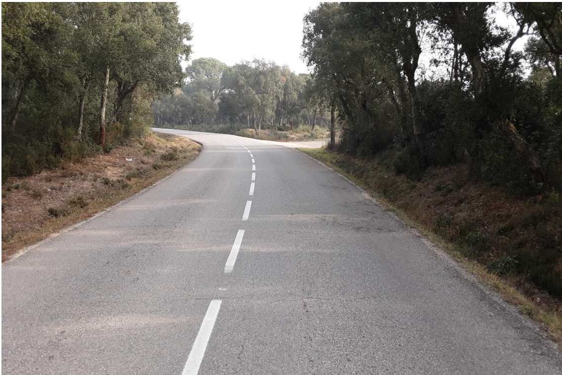
Figura 8. Vista de la calçada al PK 3+500, en sentit Calonge
