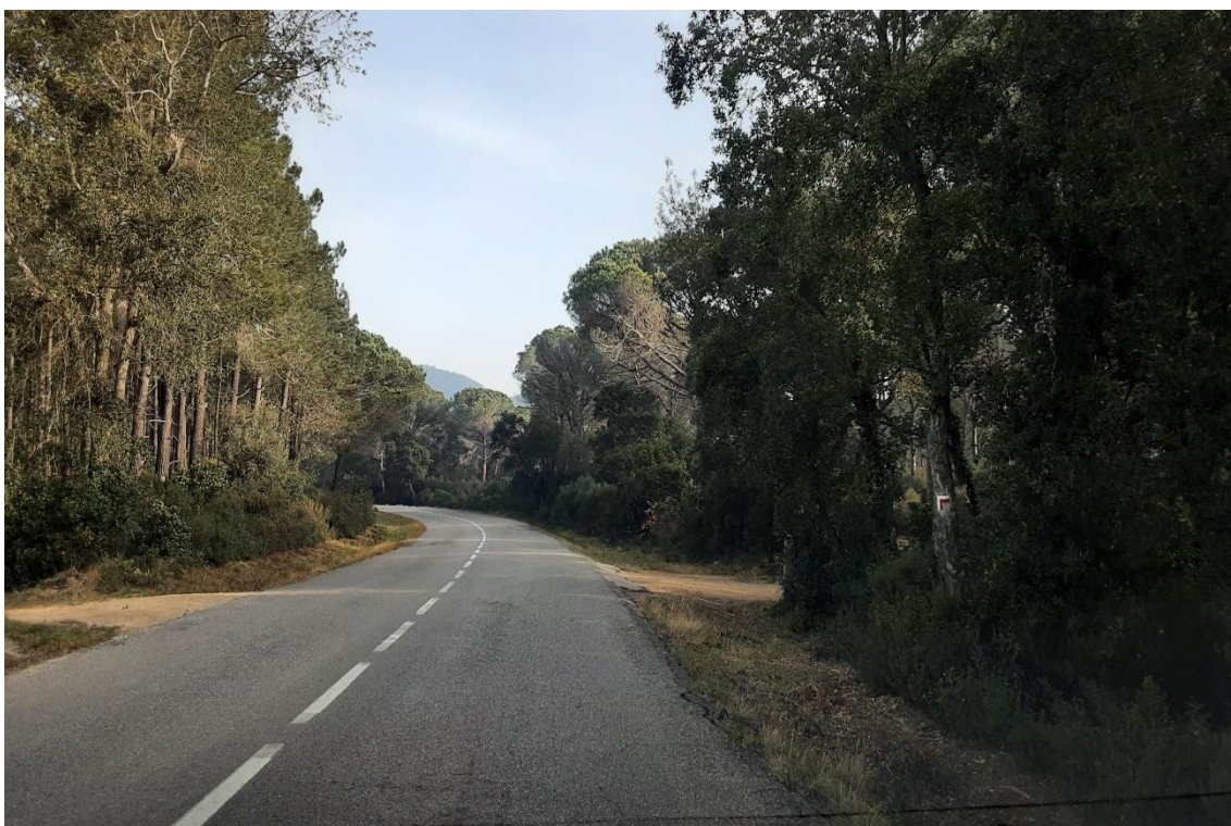
Figura 10. Vista de la calçada al PK 4+500, en sentit Calonge
