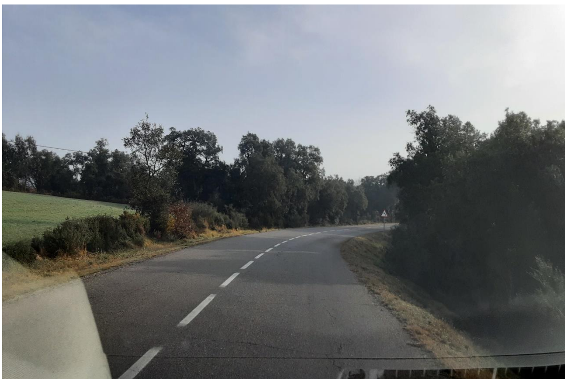
Figura 6. Vista de la calçada al PK 2+500, en sentit Calonge
