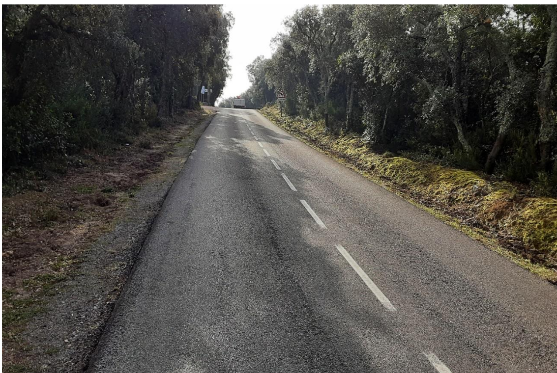
Figura 18. Vista de la calçada al PK 8+500, en sentit Calonge
