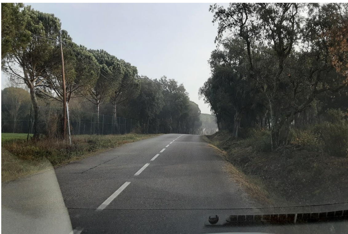
Figura 4. Vista de la calçada al PK 1+500, en sentit Calonge
