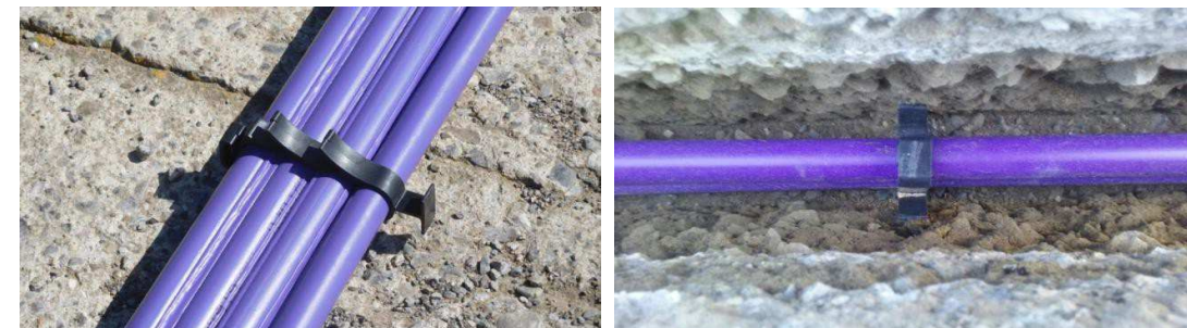
Figura 23. Centrador plàstic per homogeneïtzar la distribució del morter.
