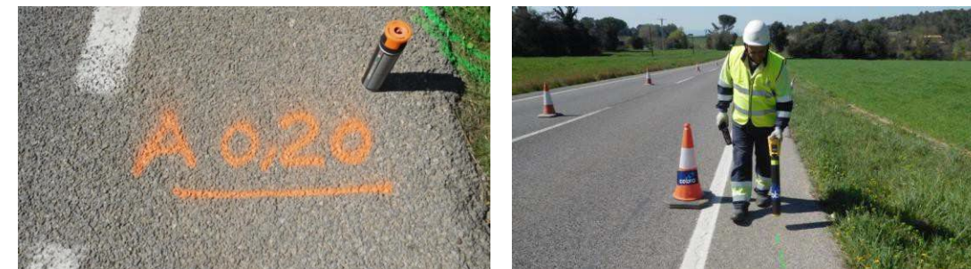
Figura 22. Localització dels serveis amb georadar
