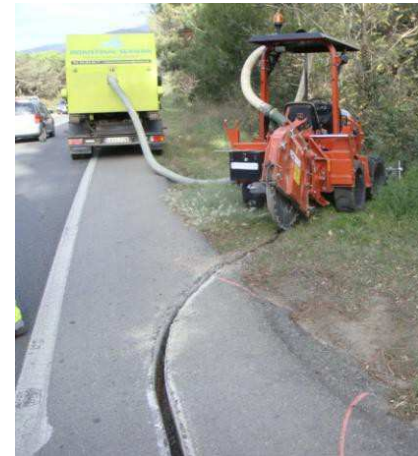
Gir de sortida de la calçada per col·locació d'un pericó
