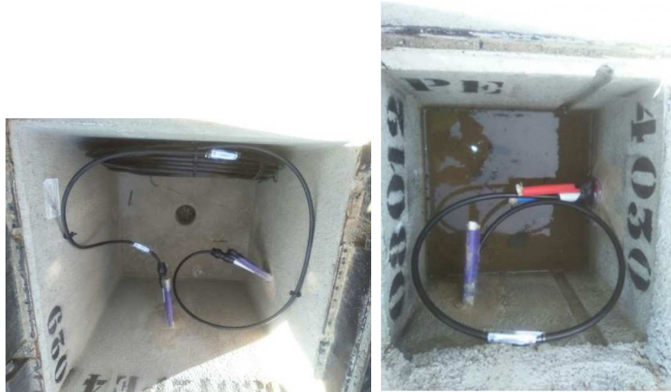
Figura 28. Exemples Terminació microductes en pericó
