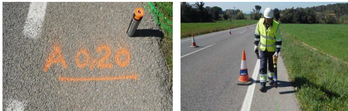
Figura 1. Localització de serveis amb georadar
