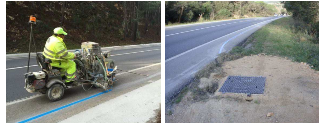
Exemple dels treballs de pintat de la línia blava Exemple de l'estat de la canalització acabada
