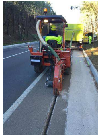
Exemple de treballs d'obertura de la microrasa
