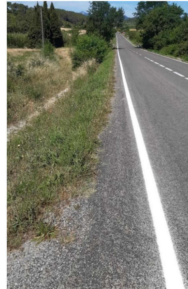
Fotografía 24 Tramo Llers - Terrades Fecha: 08/06/2021 Localización: pk 8+790 Punto de inicio de perforación dirigida para pasar recta con 3 cajones.
