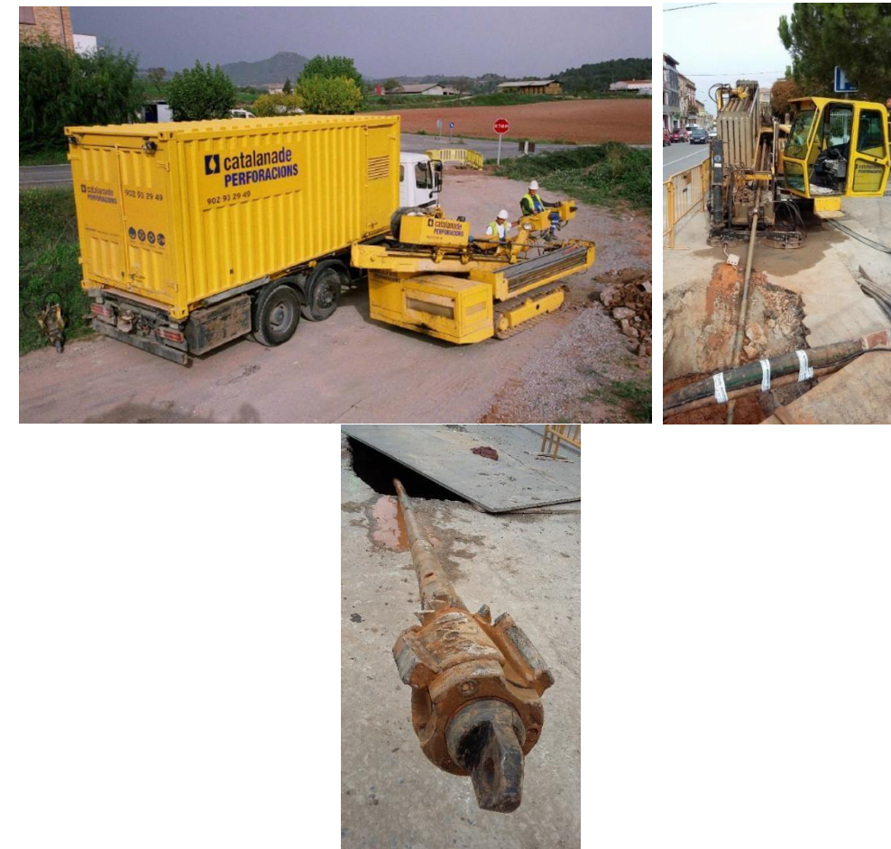
Il·lustració 22. Detalls Maquinaria Perforación Empresa Catalana perforaciones.
