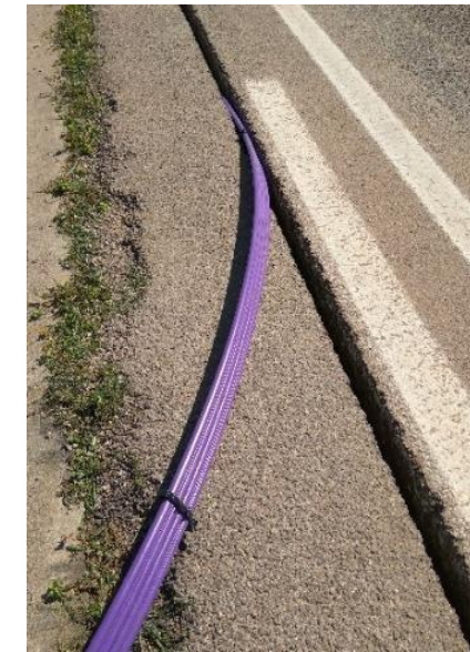
Ilustración 31. Microconductos (3 en base 1 y 4 en base 1 o 2 respectivamente).
