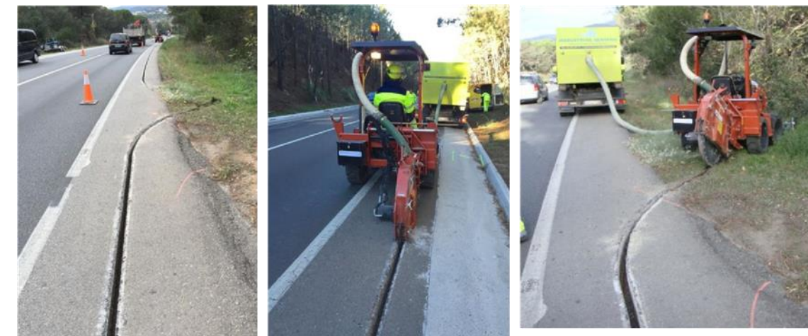
Ilustración 36. De izquierda a derecha: Ejemplo de microzanja; Ejemplo de trabajos en apertura; Giro de salida de la calzada por la microzanja, colocación de una arqueta.
