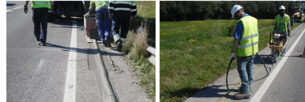
Ilustración 38. Proceso de relleno de la zanja con mortero.
