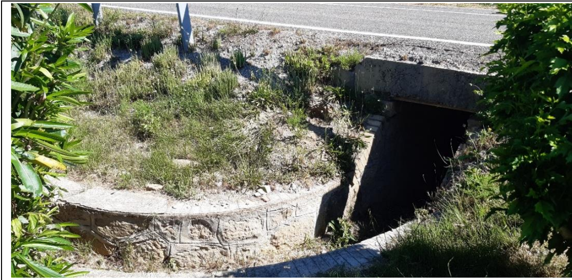
Fotografía 23 Tramo Llers – Terrades (Foto tomada en sentido contrario) Fecha: 08/06/2021 Localización: pk 8+700
