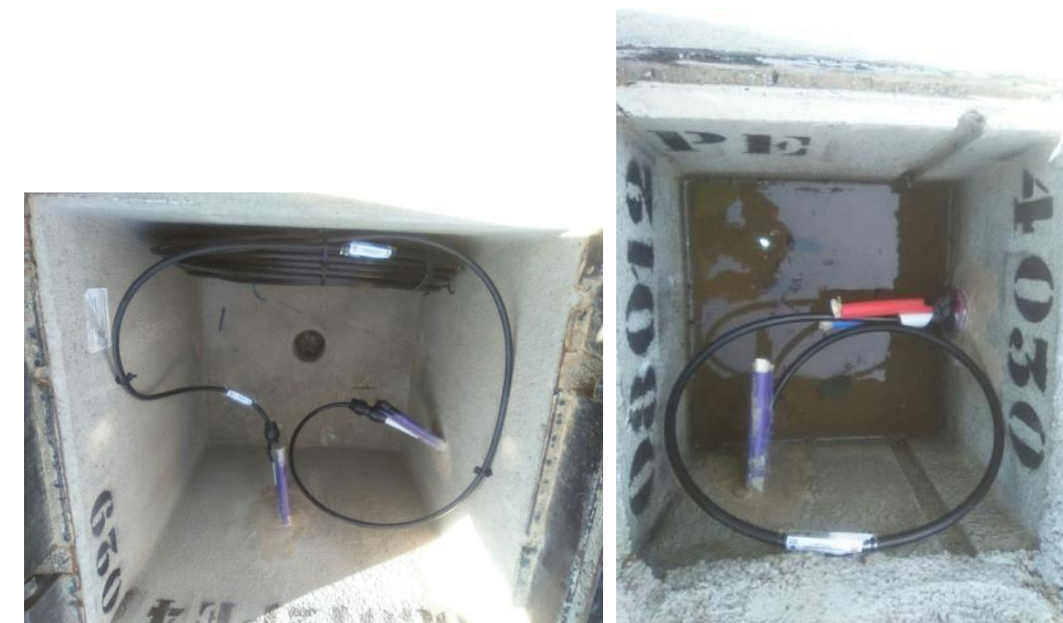
Ilustración 39. Ejemplos Terminación microconductos en arqueta.
