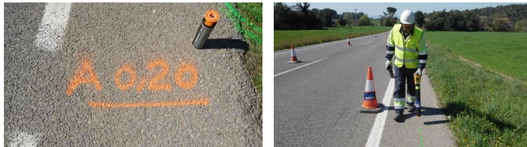
Ilustración 16. Localización de los servicios con georadar.
