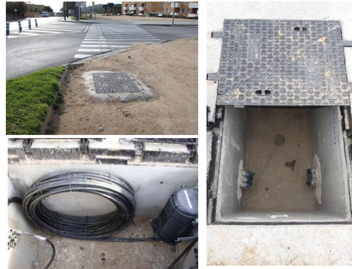
Ilustración 18. Detalle interior arquetas tipo C.
