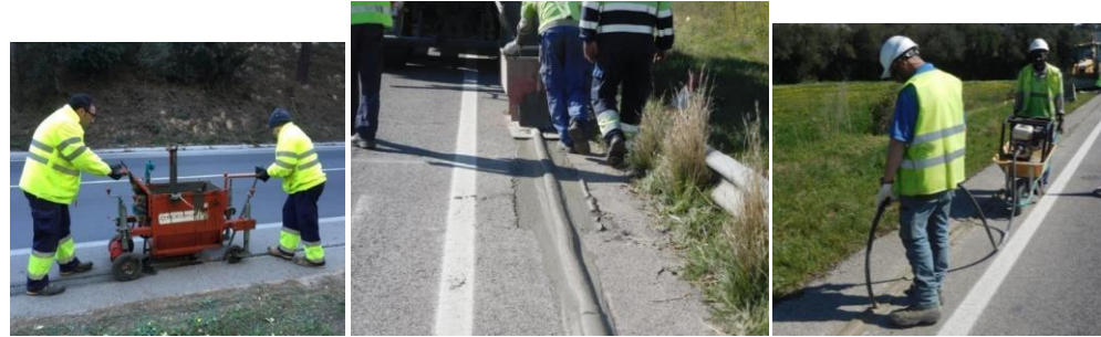
Ilustración 36. Ejemplo de trabajos de relleno de la zanja.
