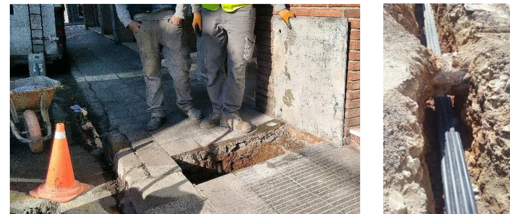
Ilustración 17. Ejemplo ejecución de calicata con detección de servicios y minado de tubería de agua.
