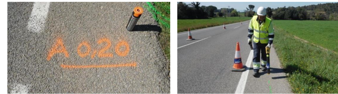
Ilustración 35. Localización de los servicios con georradar.
