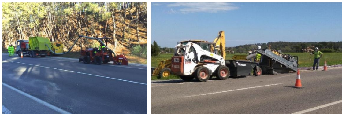
Ilustración 29. Rasero y camión de recogida de escombros.
