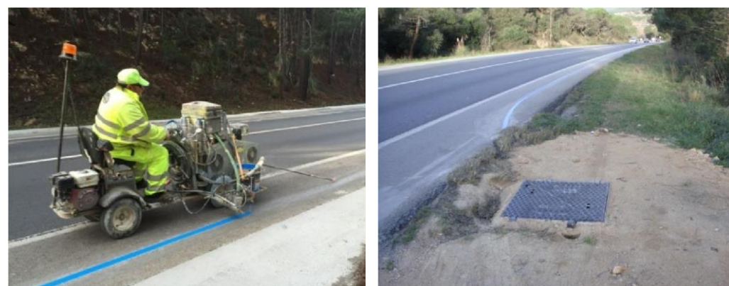
Ilustración 42. De izquierda a derecha: Ejemplo de los trabajos de pintado de la línea azul; Ejemplo del estado de la canalización terminada.
