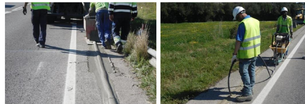
Ilustración 43. Proceso de relleno de la zanja con mortero.
