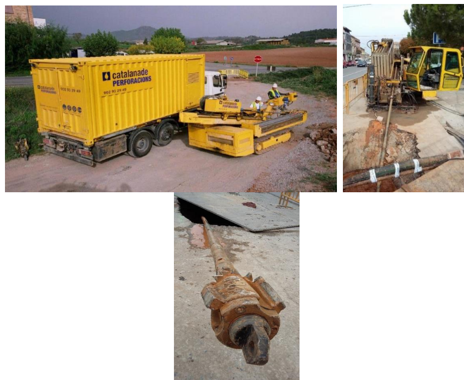
Ilustración 22. Detalles Maquinaria Perforación Empresa Catalana perforaciones.
