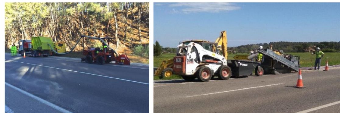
Ilustración 29. Rasero y camión de recogida de escombros.
