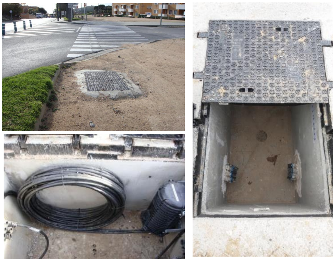
Ilustración 18. Detalle interior arquetas tipo C.
