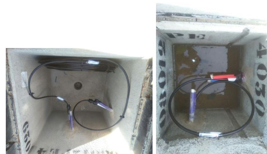
Ilustración 44. Ejemplos Terminación microconductos en arqueta.
