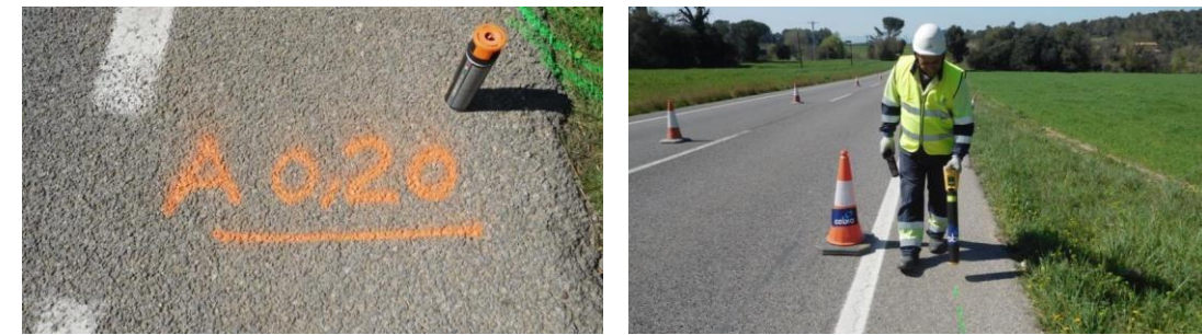
Ilustración 35. Localización de los servicios con georadar.
