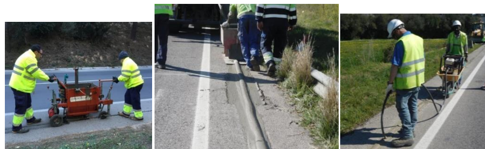
Ilustración 41. Ejemplo de trabajos de relleno de la zanja.
