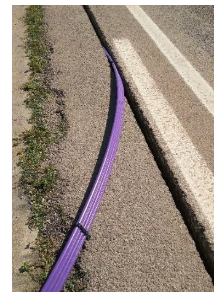
Ilustración 31. Microconductos (3 en base 1 y 4 en base 1 o 2 respectivamente).
