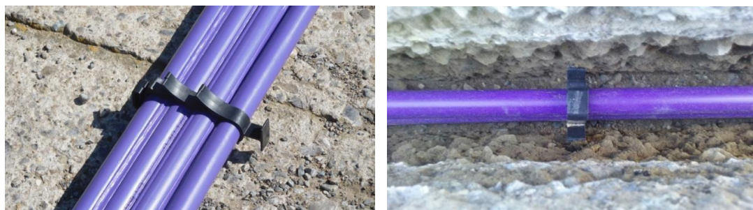
Ilustración 37. Centrador plástico para homogeneizar la distribución del mortero.
