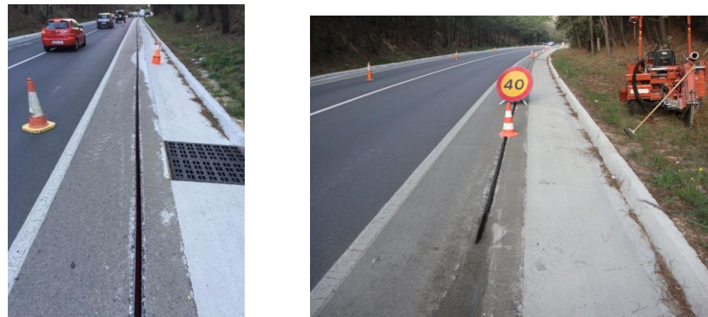
Ilustración 34. Ejemplo de señalización de la zona de trabajo en la C-65.
