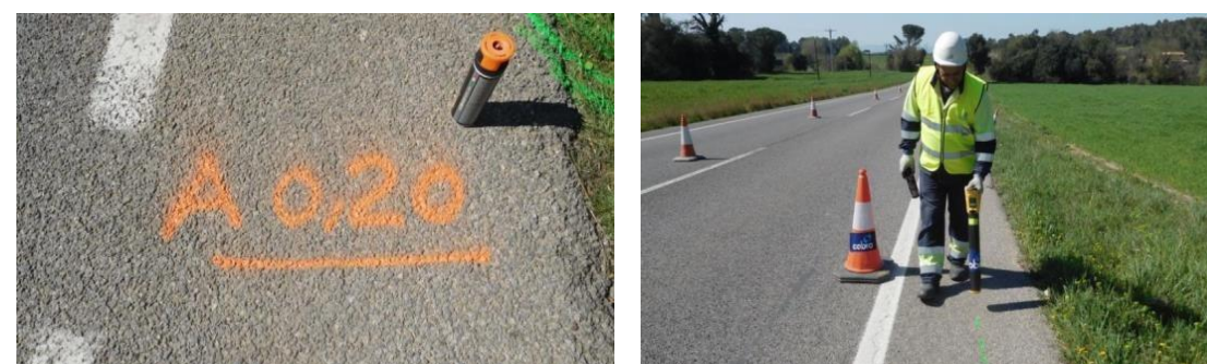
Ilustración 17. Localización de los servicios con georadar.
