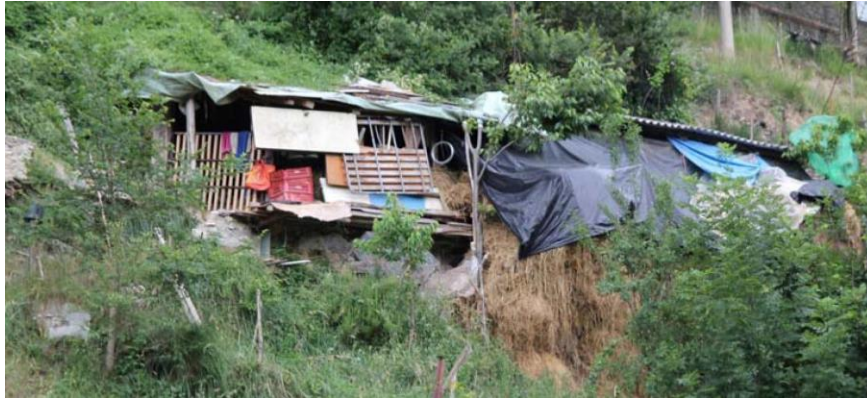
Construcció de barraques amb materials diversos, poc estables i que poden, fins i tot, contenir bestiar
