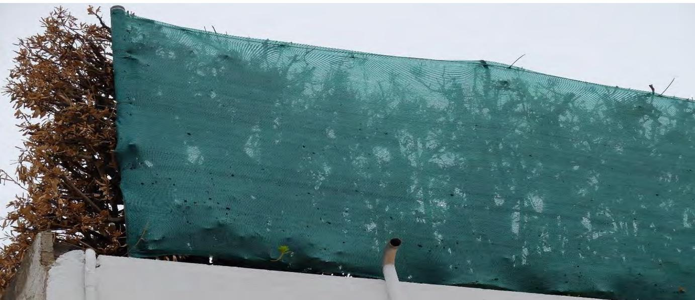
**Imagen 72.** *Detalle de cómo la malla plástica ha actuado de pantalla receptora de pavesas, apreciándose los agujeros. La vegetación posterior a la malla no se consideró suficientemente opaca y se optó por esta combinación tan peligrosa. (Fuente: Medi XXI)*
