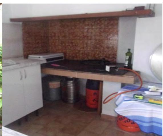
**Imagen 53.** De izquierda a derecha, bombona refugiada en el interior de la vivienda y bombona parcialmente refugiada con portón de madera combustible. (Fuente: Medi XXI)
