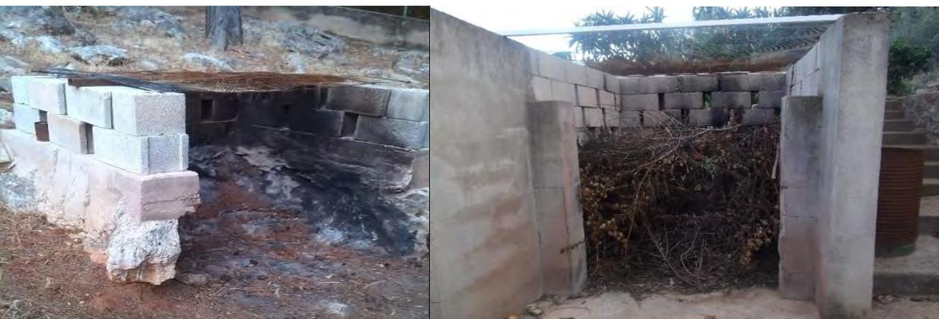
**Imagen 58.** De izquierda a derecha, quemador agrícola incorrecto, demasiado bajo y cercano a pinos, y quemador agrícola correcto. (Fuente: Medi XXI)
