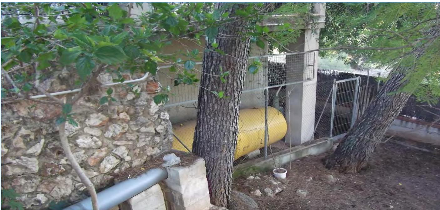
**Imagen 52.** Depósito de combustible anexo a la vivienda y sin unas correctas medidas de aislamiento. En caso de explosión, las consecuencias son imprevisibles y catastróficas. (Fuente: Medi XXI)
