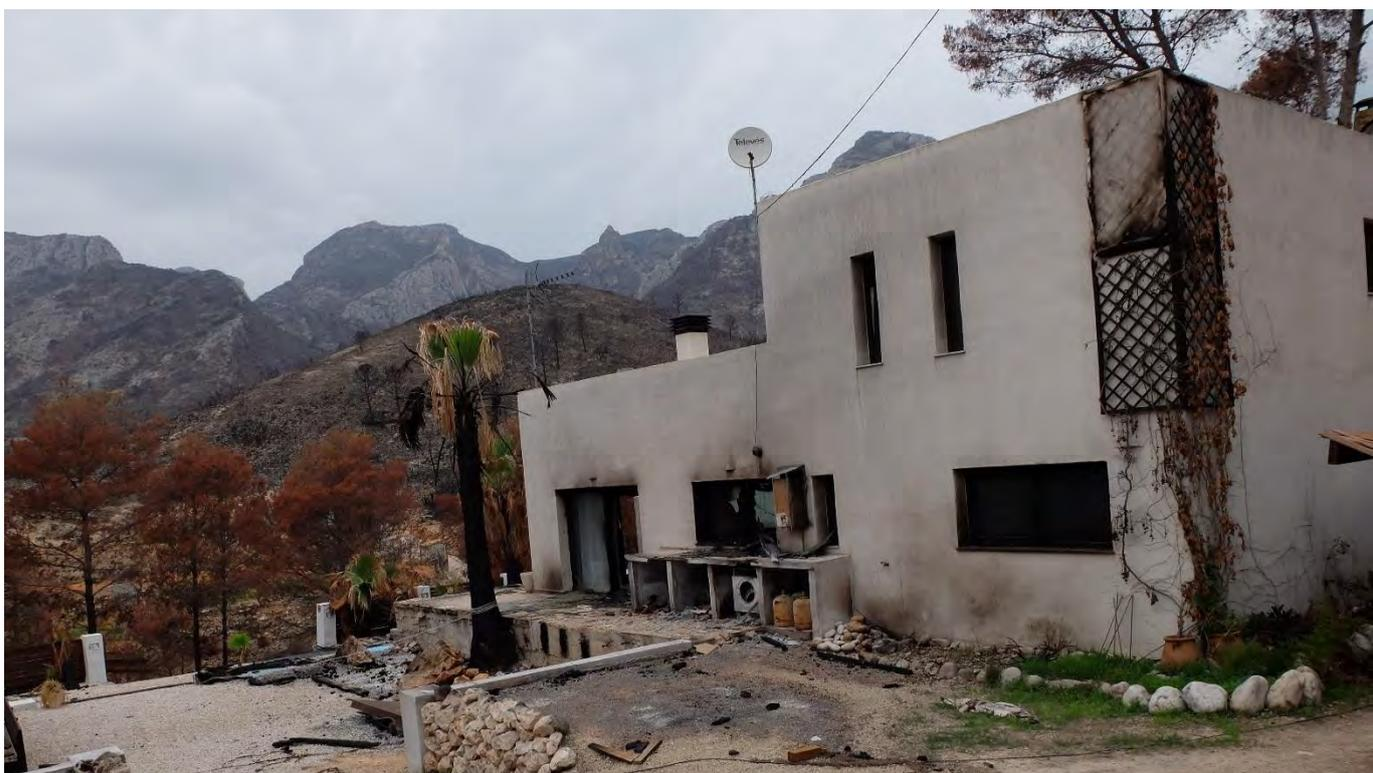
*Imagen 8. Daños en vivienda: el fuego ha vencido los cerramientos (ventanas y puertas) y ha quemado su interior, y se observa vegetación en la fachada (trepadoras) y también sobre el techo (vuelo aéreo de arbolado). (Fuente: Medi XXI)*
