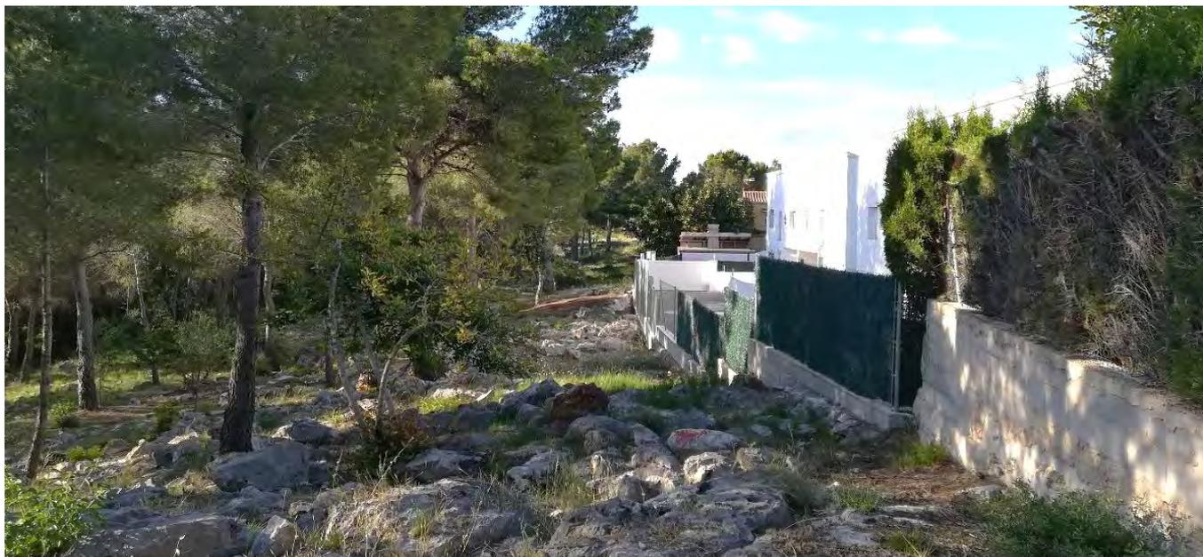
**Imagen 67.** *Franja perimetral dimensionada y ejecutada insuficientemente, en combinación con la inmediatez de la masa forestal y dos tipos de vallado parcelario muy inflamables; por un lado, el vegetal parcial de ciprés y, por el otro, malla de plástico de ocultación. (Fuente: Medi XXI)*
