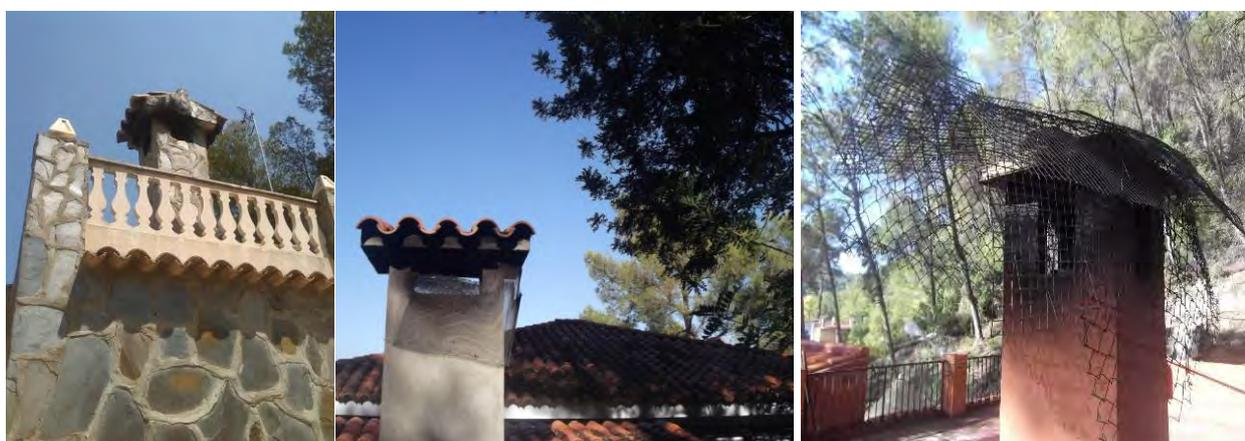
Imagen 57. *Salidas de humos incorrectas: sin rejilla matachispas, con rejilla mal colocada y malla de luz amplia.* (Fuente: Medi XXI)
