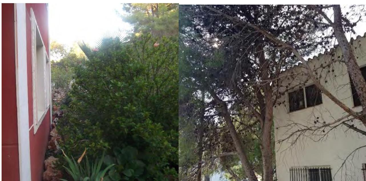
**Imagen 84.** *Incumplimientos en el anillo más inmediato de 0-3 metros. Arbustos en alineación con las ventanas (elemento vulnerable). Arbolado incluso con vuelo aéreo sobre la vivienda, muy probablemente dejado por su efecto de sombreado perenne sobre ella. (Fuente de la imagen izquierda: Medi XXI. Fuente de la imagen derecha: Lluís Regincós. Bombers de la Generalitat de Catalunya.)*
