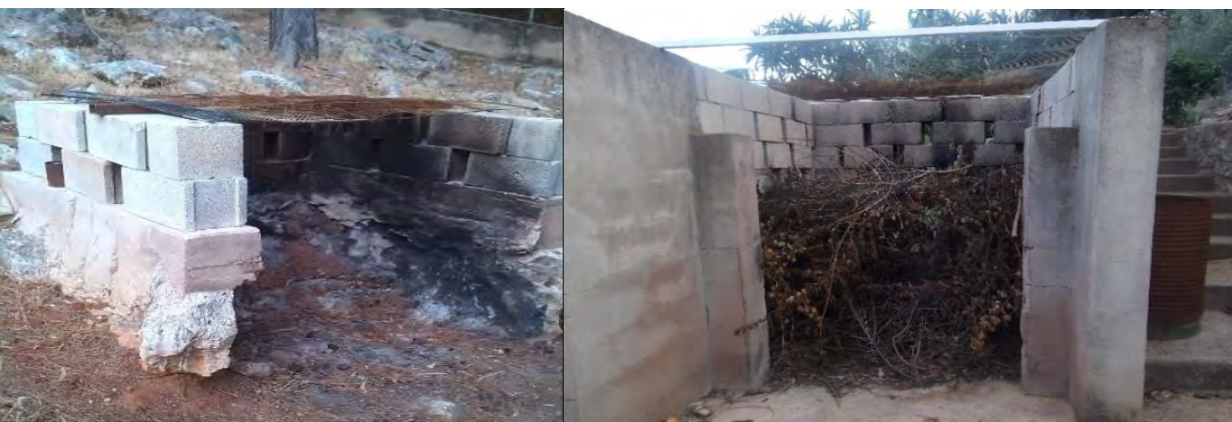
Imatge 58. D'esquerra a dreta, cremador agrícola incorrecte, massa baix i proper a uns pins, i cremador agrícola correcte. (Font: Medi XXI)
