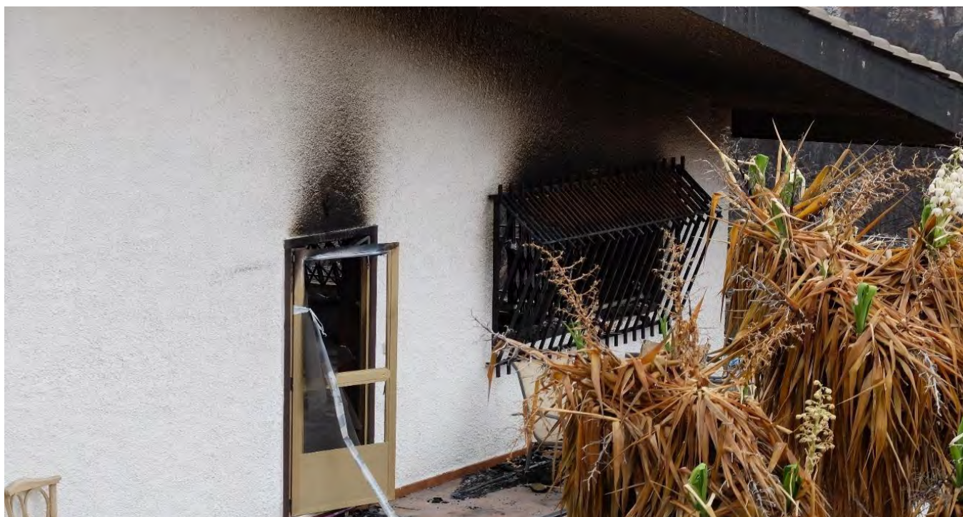
Imatge 82. Independentment de la selecció de l'espècie, en aquest cas iuca (Yucca arborea) poc inflamable, la vegetació mal disposada espacialment i prop d'elements vulnerables, com finestres i portes, pot suposar o no l'afectació greu o lleu d'un habitatge, segons la intensitat del foc. (Font: Medi XXI)
