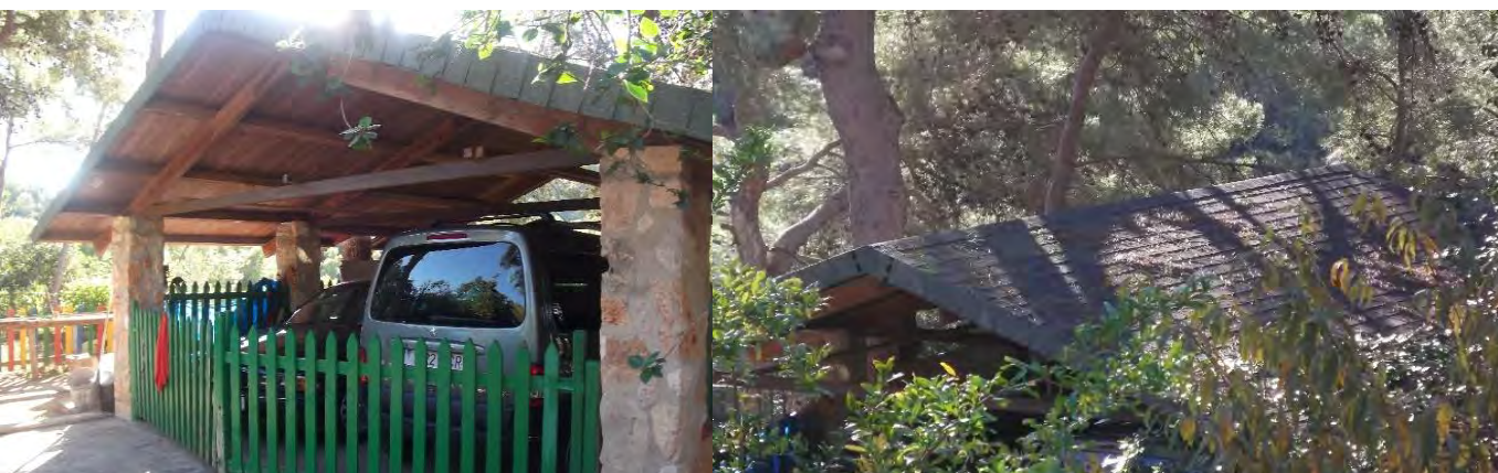
Imatge 56. Cotxera fabricada amb fusta i plàstic sota una pineda i coberta d'acícules mortes. (Font: Medi XXI)
