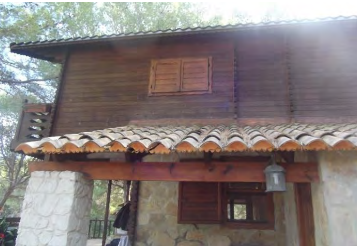
Imatge 30. Combinació de revestiment de pedra, molt resistent, amb làmines de fusta, molt combustible, en un entorn eminentment forestal. (Font: Medi XXI)
