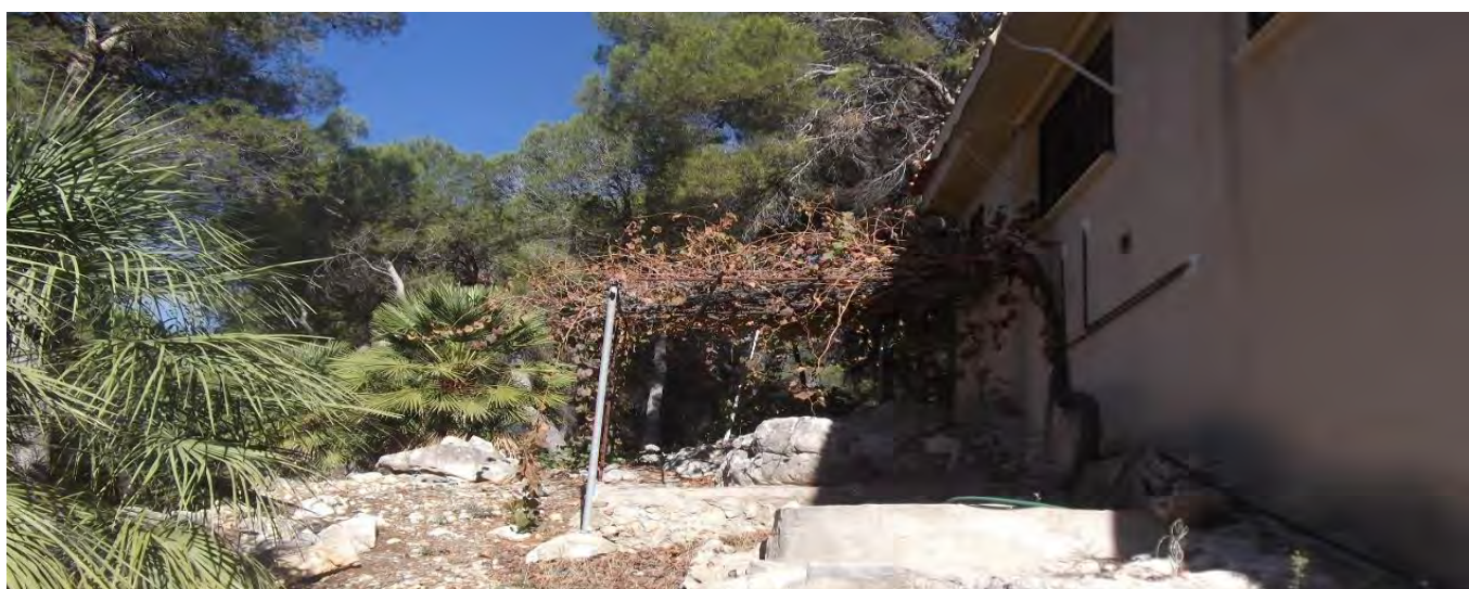
Imatge 55. Coberta de vinya (Vitis vinifera) morta i seca, altament combustible i als voltants de la finestra, part vulnerable de l'habitatge. (Font: Medi XXI)
