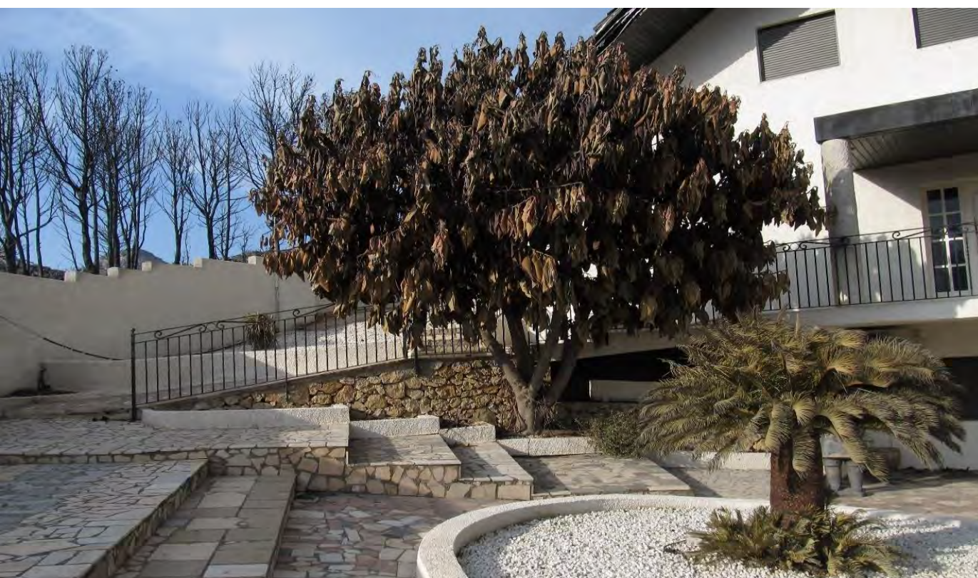
Imatge 81. En ocasions puntuals, l'arbratge —segons l'espècie— absorbeix l'impacte del foc sobre l'habitatge. Com a recomanació general, la presència d'arbratge en els voltants de l'habitatge és perjudicial pel risc que comporta durant l'emergència. (Font: Medi XXI)
