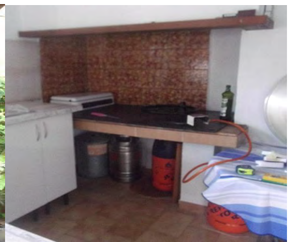
Imatge 53. D'esquerra a dreta, bombona tancada a l'interior de l'habitatge i bombona parcialment tancada amb una contraporta combustible. (Font: Medi XXI)
