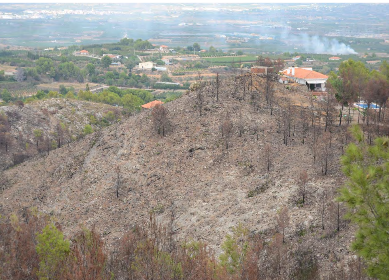
Imatge 7. Habitatge autoprotegit dalt d'un turó que ha resistit l'impacte d'un foc. La discontinuïtat que hi ha amb la massa forestal que l'envoltava, juntament amb una escassa vegetació al jardí i una elecció adequada de materials de construcció resistents, n'asseguren el manteniment, la qual cosa pot ser la recepta fins i tot per a ubicacions desfavorables d'habitatges. (Font: Medi XXI)
