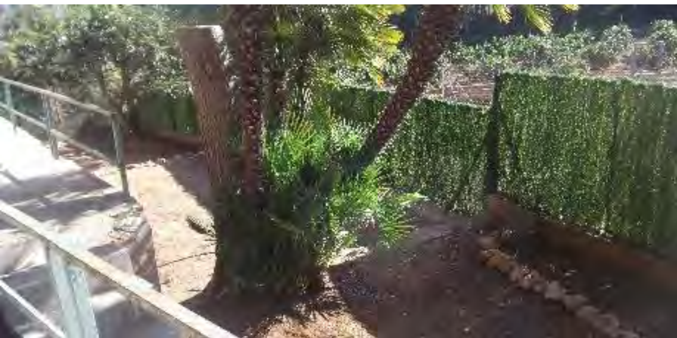
Imatge 60. Exemple d'una tanca perimetral de malla de plàstic, que simula una tanca viva, disposada sobre filferro i a prop d'un peu de margalló ( Chamaerops humilis ), una espècie molt inflamable, malgrat que rebrota després de l'incendi. Es troba alineat amb l'entrada a l'habitatge. (Font: Medi XXI)
