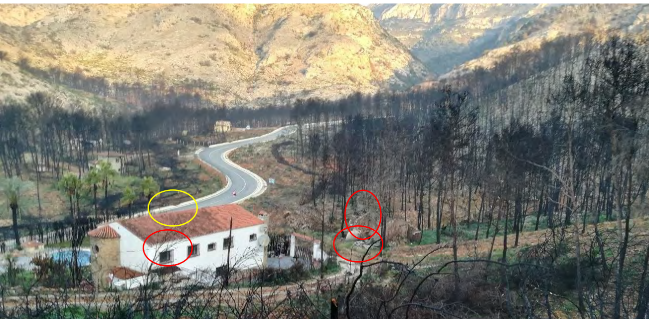
Imatge 64. El material de construcció emprat en l'habitatge ha resistit una alta intensitat de foc i l'afectació parcel·lària es resumeix en la crema de la tanca vegetal de xiprer, malgrat les discontinuïtats amb la massa forestal existents (vies de comunicació). Les palmes seques acumulades per manca de poda a les palmeres s'han cremat, i la part viva roman en el paisatge. (Font: Medi XXI)
