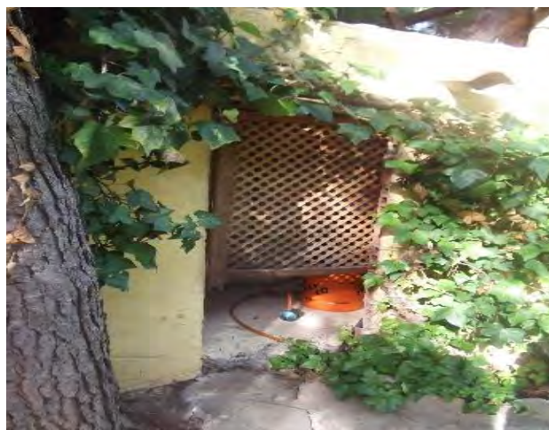
Imatge 53. D'esquerra a dreta, bombona tancada a l'interior de l'habitatge i bombona parcialment tancada amb una contraporta combustible. (Font: Medi XXI)
