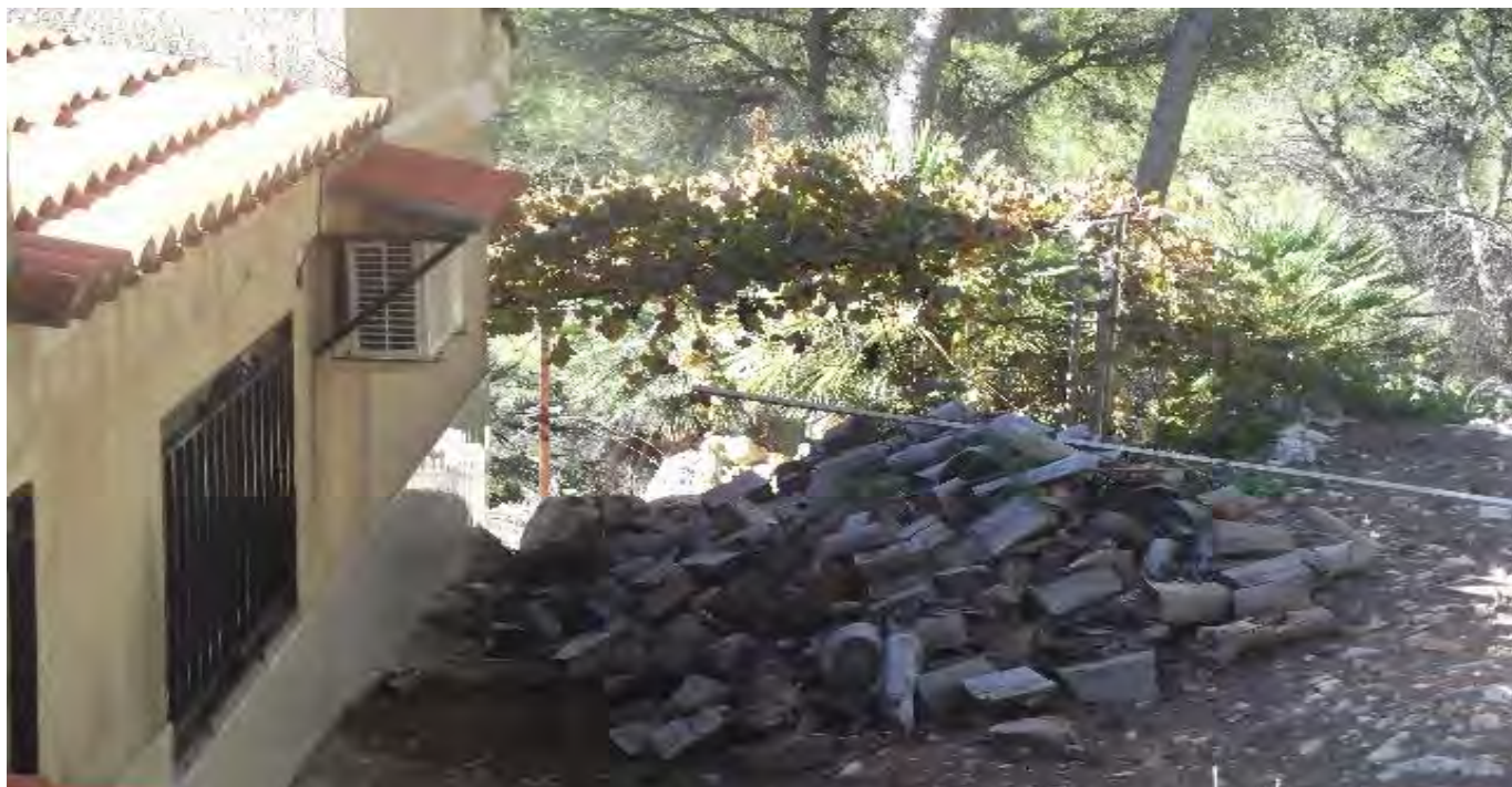
Imatge 50. Punt d'aplegament incorrecte, sense cobertai prop d'una finestra (part vulnerable de l'habitatge). (Font: Medi XXI)
