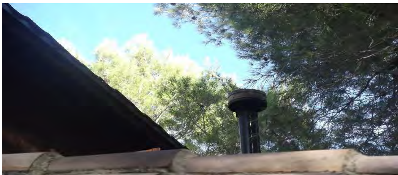
Imatge 29. Vegetació propera a una sortida de fums (xemeneia). No es compleix la distància mínima preventiva de 3 metres. (Font: Medi XXI)
