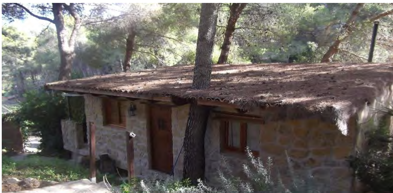
Imatge 27. Casa amb teulada de teula de terrissa. Encara que l'edificació sigui de pedra, l'acumulació de restes vegetals a sobre l'exposa a la calor. (Font: Medi XXI)
