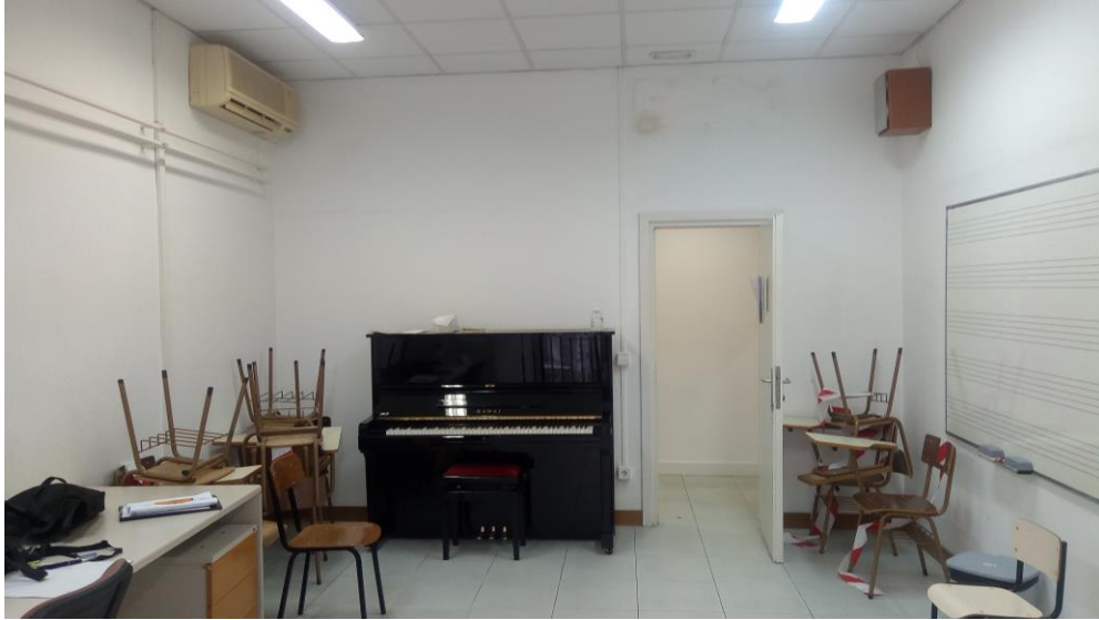
Sector A (aula a transformar en bloc de banys)
